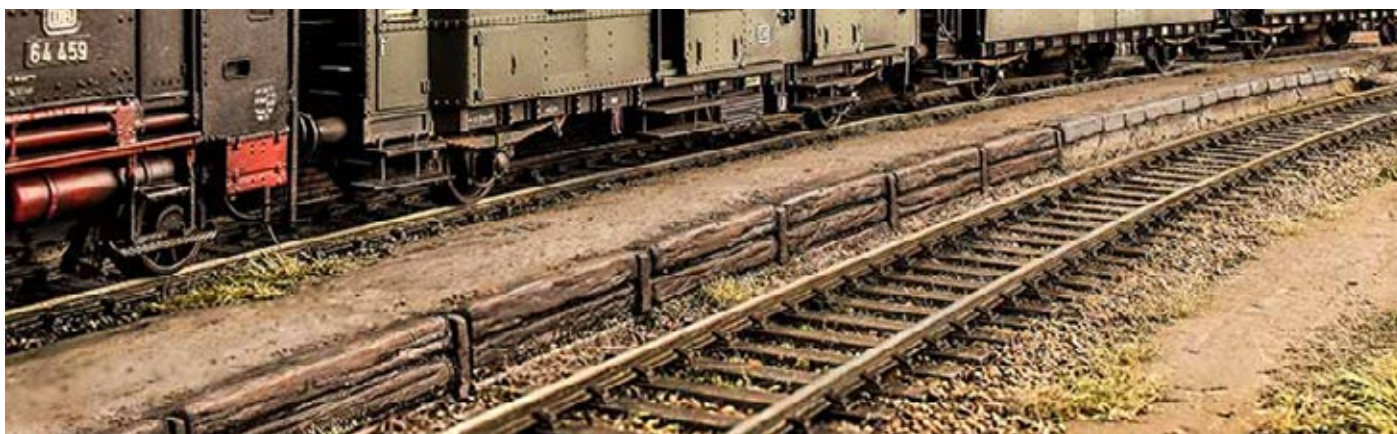
Abb.: Schüttbahnsteig 2158 mit Schwellen, hinten mit Steinkante. 2159.
