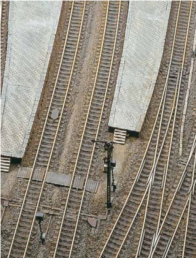
Abb.: Hohe Bahnsteige, gebaut mit Bahnsteigkanten 2213 und Belag 2141
